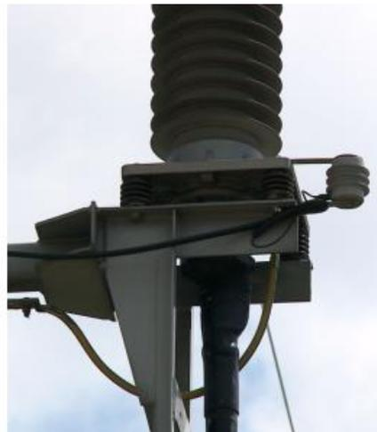
*Измерительный конденсатор LDWS-T: слева – общий вид, справа – установленный на конце линии*
